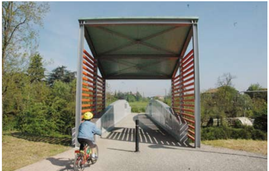
Il ponte ciclo-pedonale sul Crostolo
