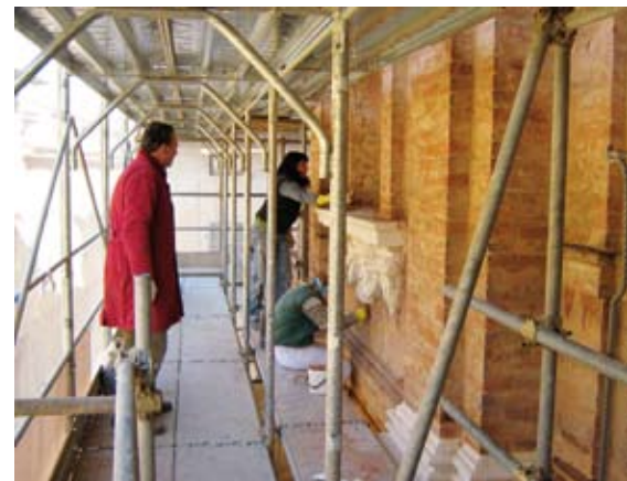
Una fase dei lavori di pulitura della facciata di San Giorgio e, in alto, gli ornamenti in marmo ora risaltano sulla facciata
